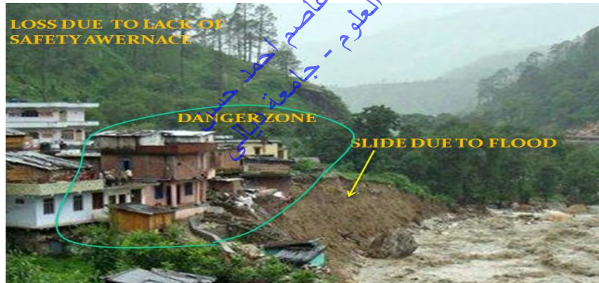
انزلاق التربة بسبب المياه مما يعرض المنازل للانهيار (غياب التوعية المطلوبة)
