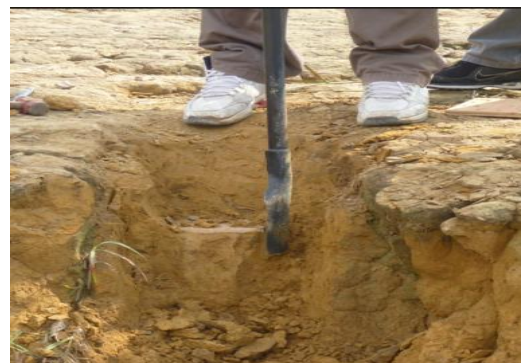
الطريقة اليدوية لعمل حفرة الاختبار
