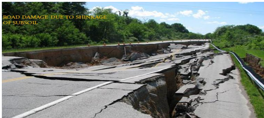
تهدم الطرق نتيجة لتقلص التربة
